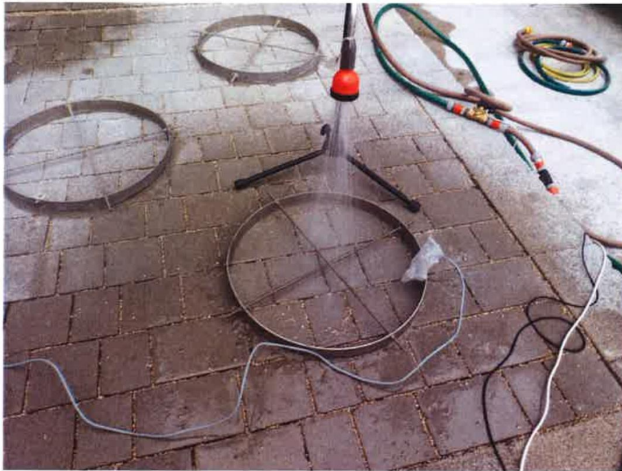
Bild 1: Ansicht der errichteten Musterfläche
